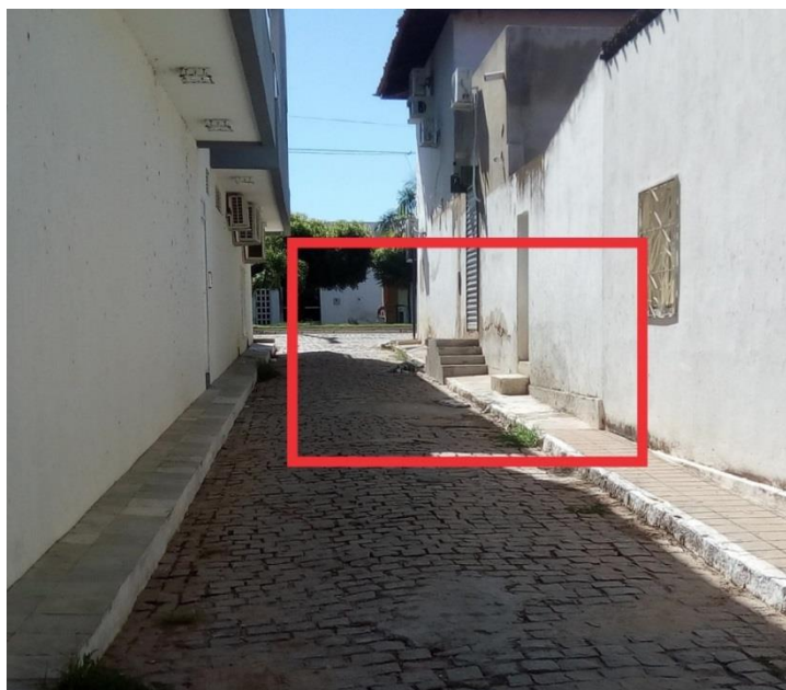
Figura 10. Ocupação indevida da calçada pela construção de degraus.
