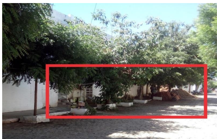
Figura 13. Obstrução da calçada pela construção de degraus e materiais de construção
