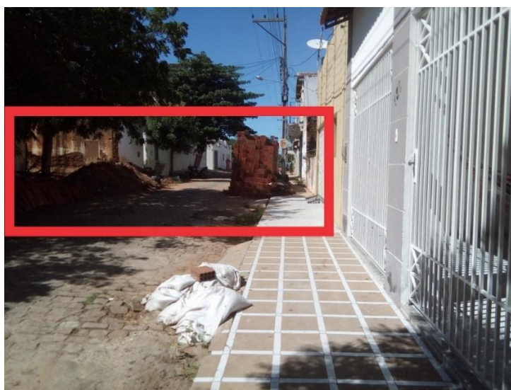
Figura 12. Interdição de parte da calçada por materiais de construção
