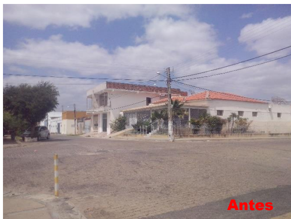
Figura 26: Situação atual sem sinalização.
