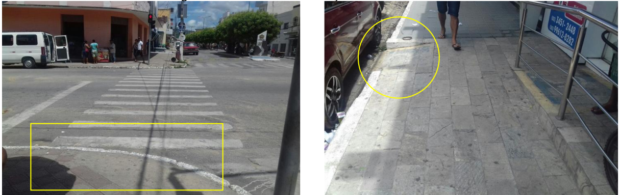
Figura 15: Travessias e calçadas inacessíveis.
